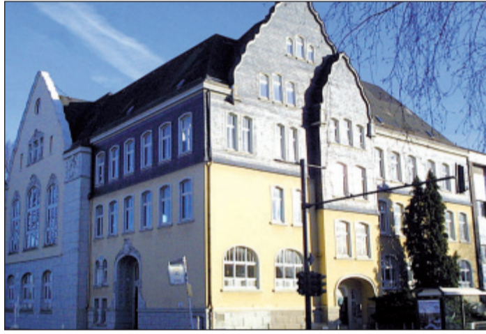
Hinter dem denkmalgeschützten Schulgebäude an der Berghäuser Straße soll die neue Cronenberger Sporthalle errichtet werden - es fragt sich neuerdings wieder, wann damit begonnen wird...
