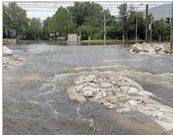
Rauschende Wassermassen: Der Damm zum Stadtteil Rothensee wurde geöffnet, damit das Kraftwerk gesichert werden konnte.
