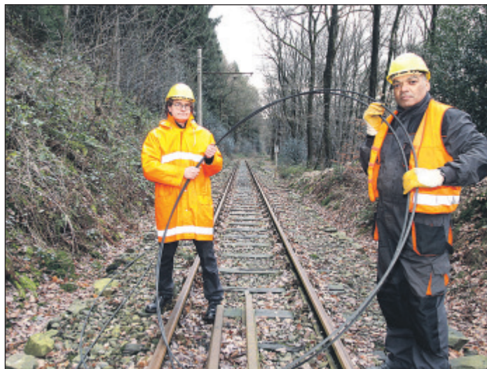
Geschockt: Sascha Odenthal und Jörg Rudat verschafften sich am Montagvormittag ein Bild von den Schäden, welche die Täter diesmal an der Straßenbahn-Strecke angerichtet hatten.
