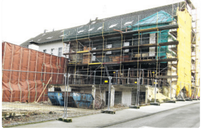
Nun soll es hier aber tatsächlich weitergehen: das ehemalige akzentra-Gebäude an der Hauptstraße von der Rückseite gesehen. | Foto: mko.
