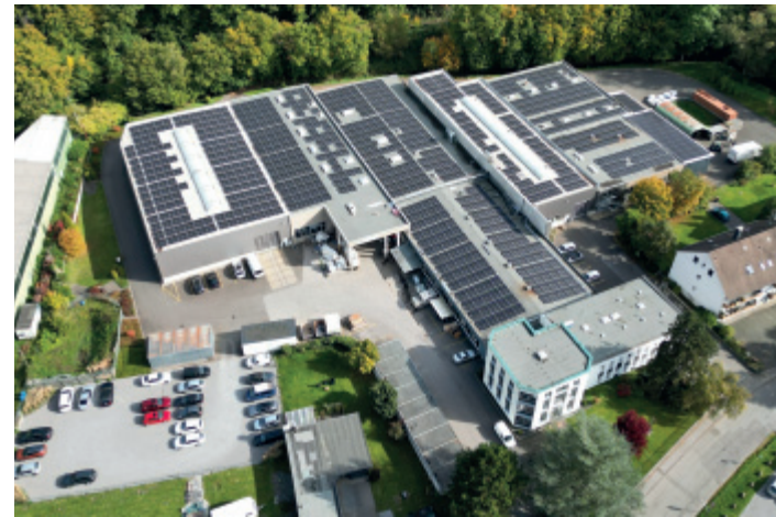
Die PV-Anlage der Berger-Gruppe ist mit 1.800 Panels auf 5000 Quadratmetern und einer Leistung von 700 kWp die drittgrößte Anlage in Wuppertal. Die Jahresproduktion liegt bei 540.000 Kilowattstunden. | Foto: WSW
